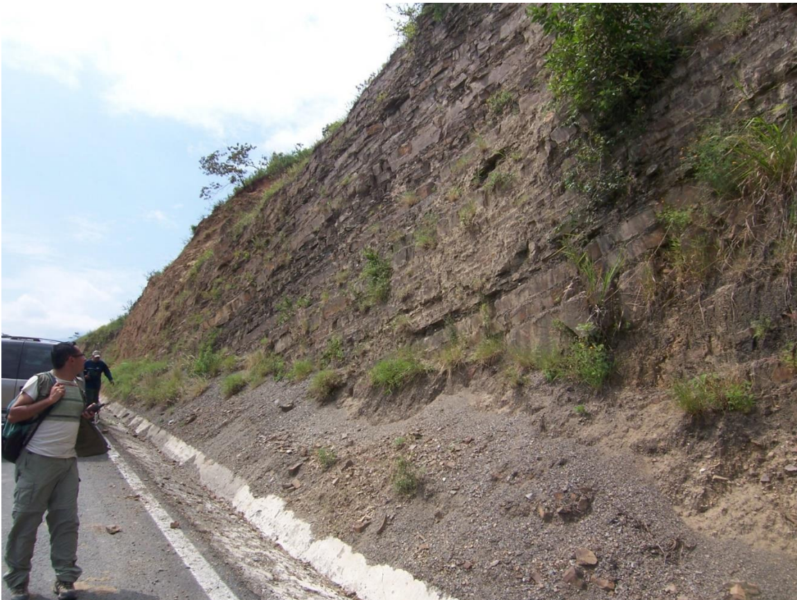
Imagen V.8. Ladera de caliza-lutita con procesos de derrumbes.
