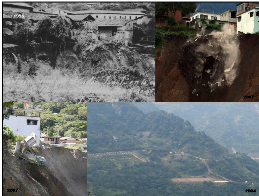
Imagen I.2. Deslizamientos en Pahuatlán del Valle.
